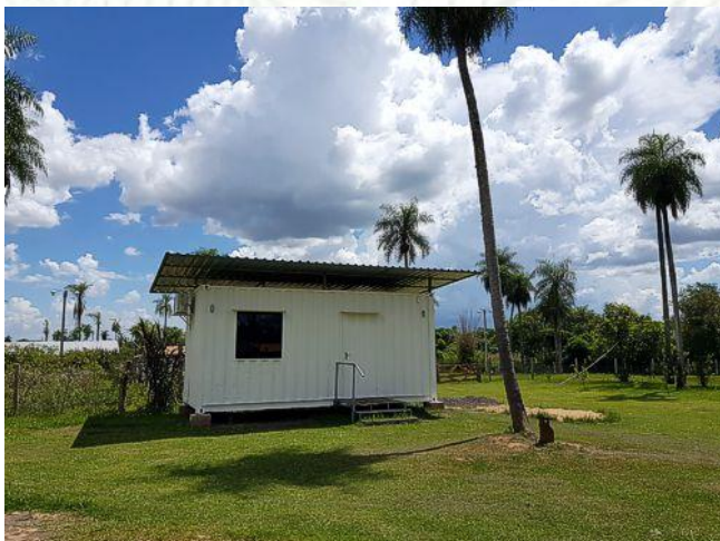
Wohncontainer mit Überdach gegen Sonnenwärme
