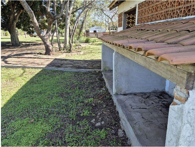
Das überdachte Holzlager vor dem Grillhaus
