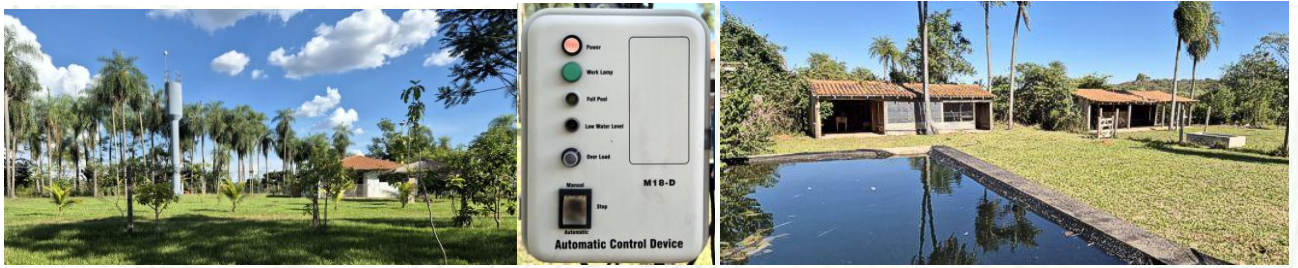
Brunnen und Wasserturm mit automatischer Steuerung, ausreichend für Haus, Pool, Garten und Tiere
