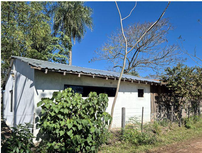
Blick von Außen auf den Wohnteil
