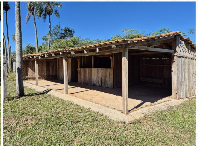
alle Drei Bereiche des Unterstandes
