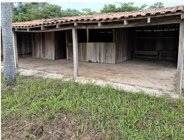
Betonuntergrund, Massivholz und Ziegeldach
