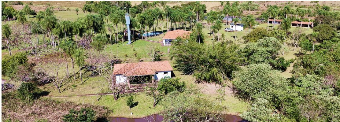
Auf dem gesamten Grundstück sind unterirdische Leitungen zu zahlreichen Wasseranschlüssen und Laternen. Auch Kamerakabel sind bei Bedarf verfügbar.
