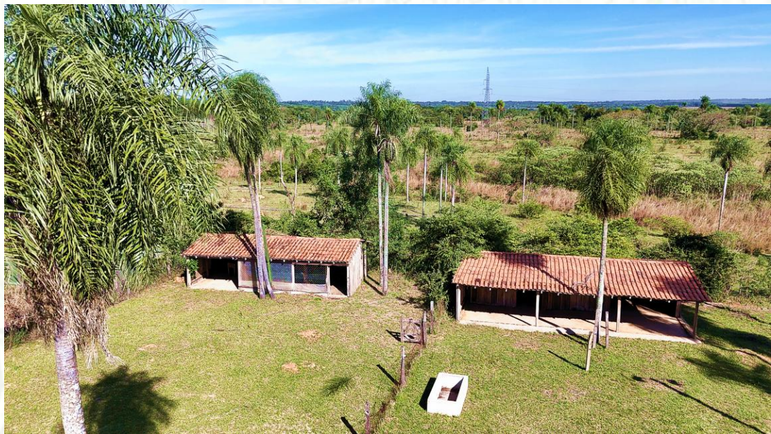
links der Kleintierstall, rechts der Großtierunterstand
