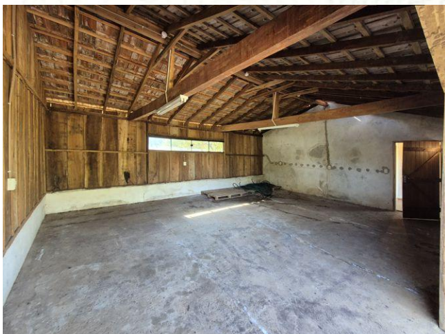
Der große Lagerraum mit Fenster
